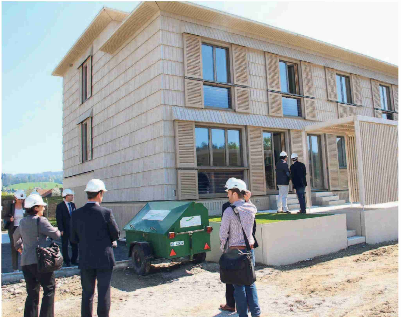
Das erste fertiggestellte Reiheneinfamilienhaus der Grossüberbauung Neugrüen.
